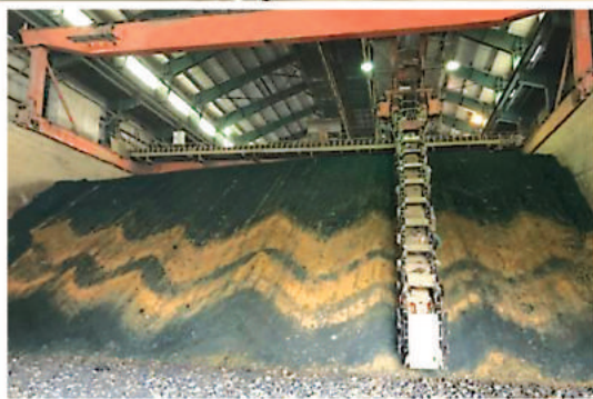
Kho nguyên liệu đá sét sức chứa 7.000 tấn Clay material warehouse with a capacity of 7,000 tons
