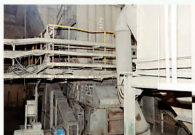
02 máy cán đá sét năng suất 250 t/h 02 Clay crusher with capacity of 250 t/h
