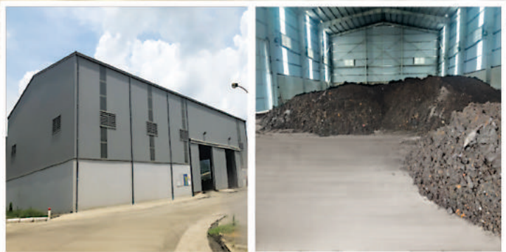
Kho chứa bùn thải nguy hại diện tích 1080m 2 Hazardous sludge storage
