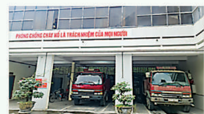
Phương tiện phòng cháy chữa cháy
